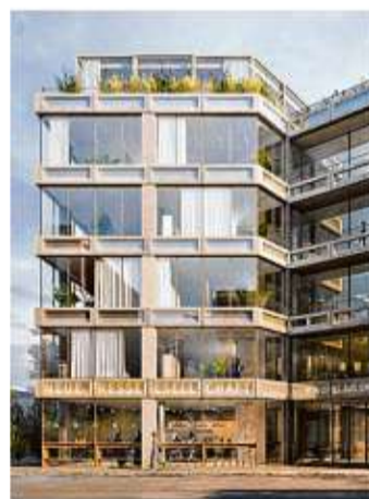
Blick von der Olgastraße auf einen Teil des künftigen Medienhauses. Visualisierung: Forbes Massie Studio
