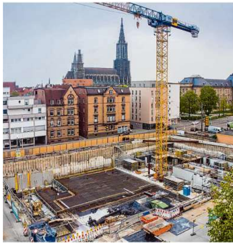
Blick in die Baugrube: Das Medienhaus entsteht an zentraler Stelle in der Stadtmitte. Foto: Volkmar Könneke
