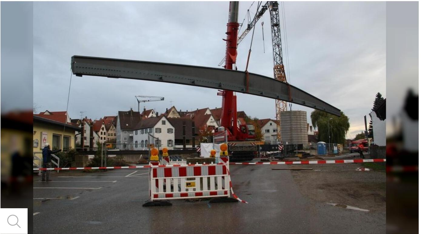
Der erste der beiden 25 Tonnen schweren Längsträger wird mit dem Autokran abgeladen. (Foto: Marion Buck)
