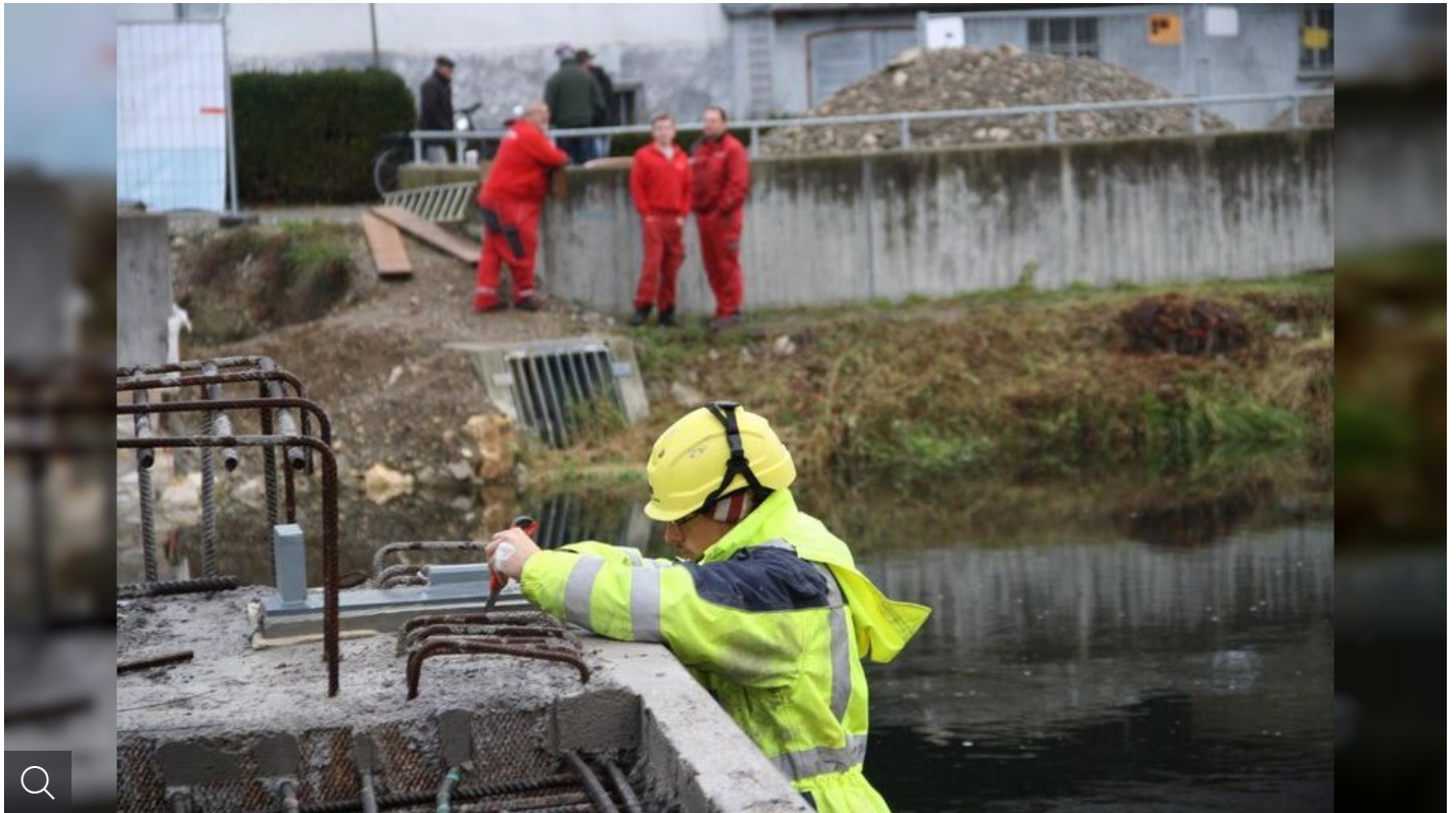
Neue Holzbrücke wird gesetzt (Foto: Marion Buck)
