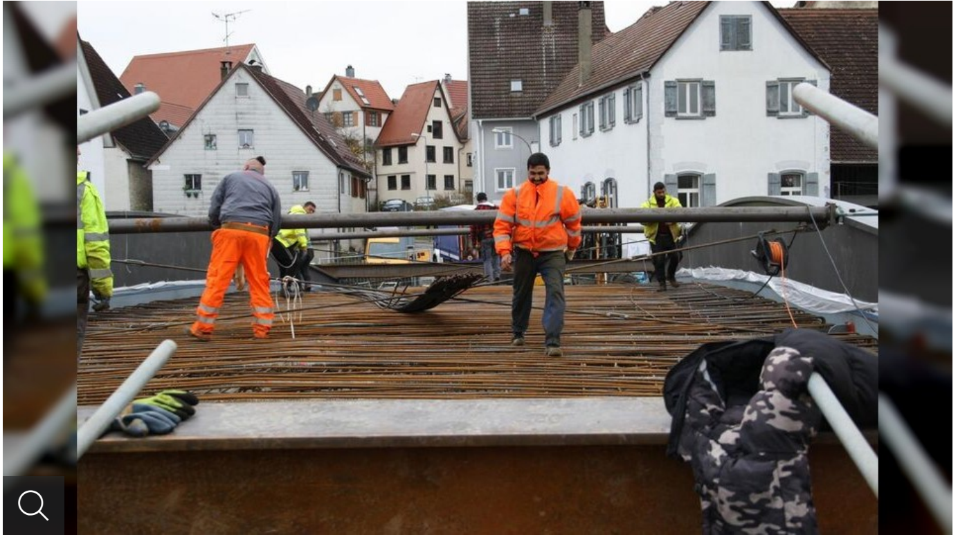
Im Boden spannt sich die Brücke über die Donau. (Foto: Marion Buck)
