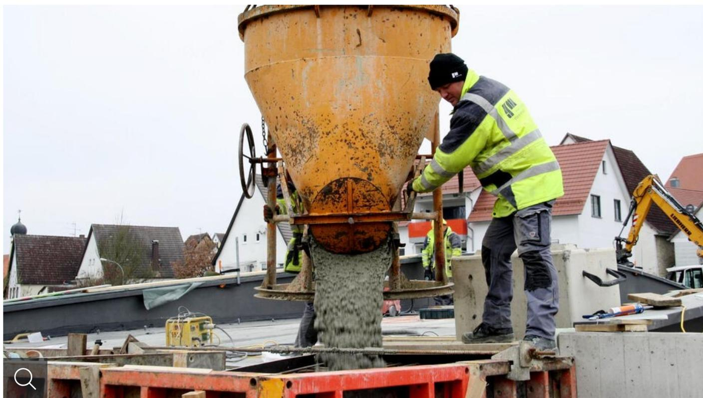
Die Übergangsbalken wurden am Montagmorgen an der Holzbrücke betoniert. (Foto: Marion Buck)
